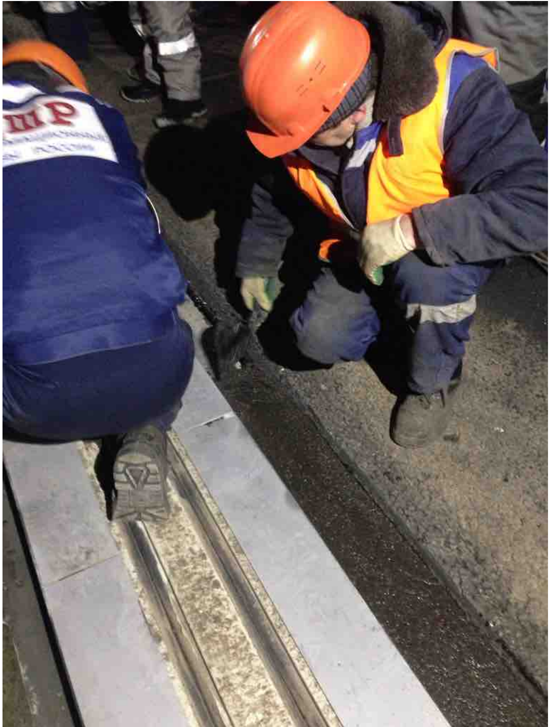
Заполнение штрабы полимербетоном «ДШКРИТФЛЕКС»
