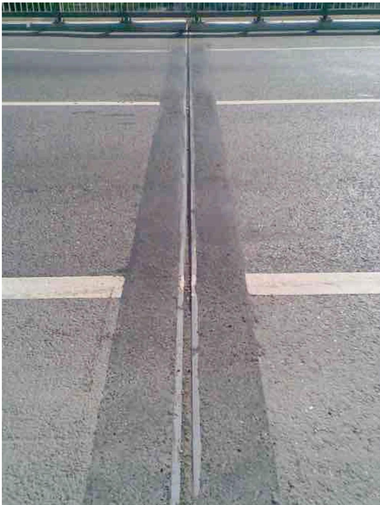
**Переходная зона сопряжения асфальтобетонного покрытия с деформационным швом - ПУГМК (VJ BAUM) на мосту через реку Бзугу автомобильной дороги Джубга-Сочи (Новороссийск-Тбилиси-Баку) на участке обхода г.Сочи.**
