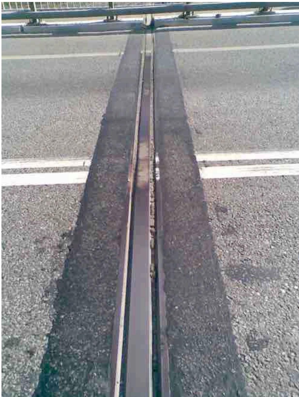
**Переходная зона сопряжения асфальтобетонного покрытия с деформационным швом ПУГМК (VJ VAUM) на Мосту через р.Ликова на ПК71 Боровского шоссе**
