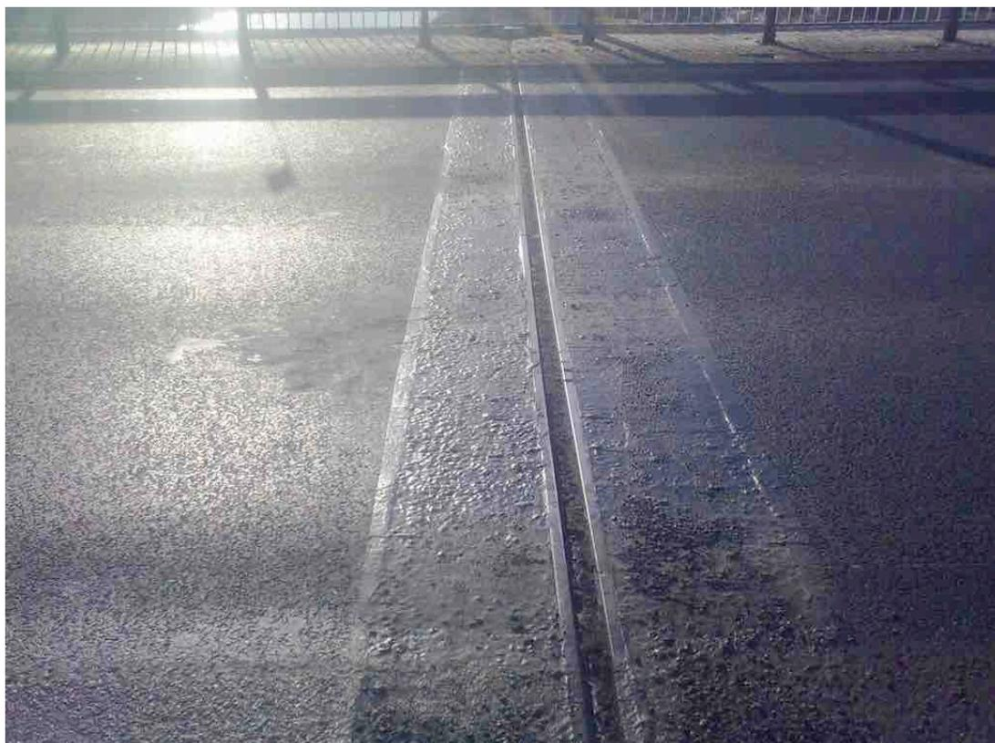
**Переходная зона сопряжения асфальтобетонного покрытия с деформационным швом - ПУГМК (VJ BAUM) на эстакаде на выезде из ММДЦ «Москва-Сити» 2011 г.**
