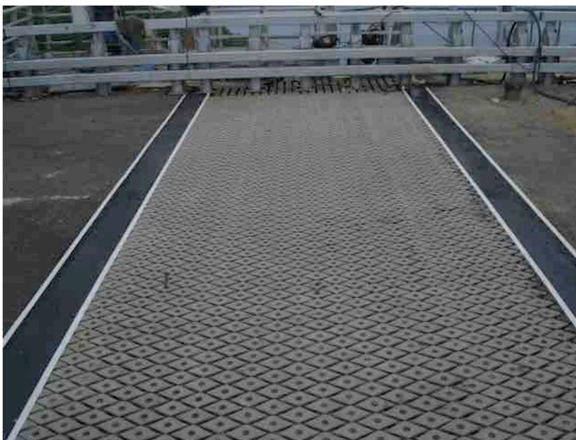
**Переходная зона сопряжения асфальтобетонного покрытия с деформационным швом - ПУГМК (VJ BAUM)
