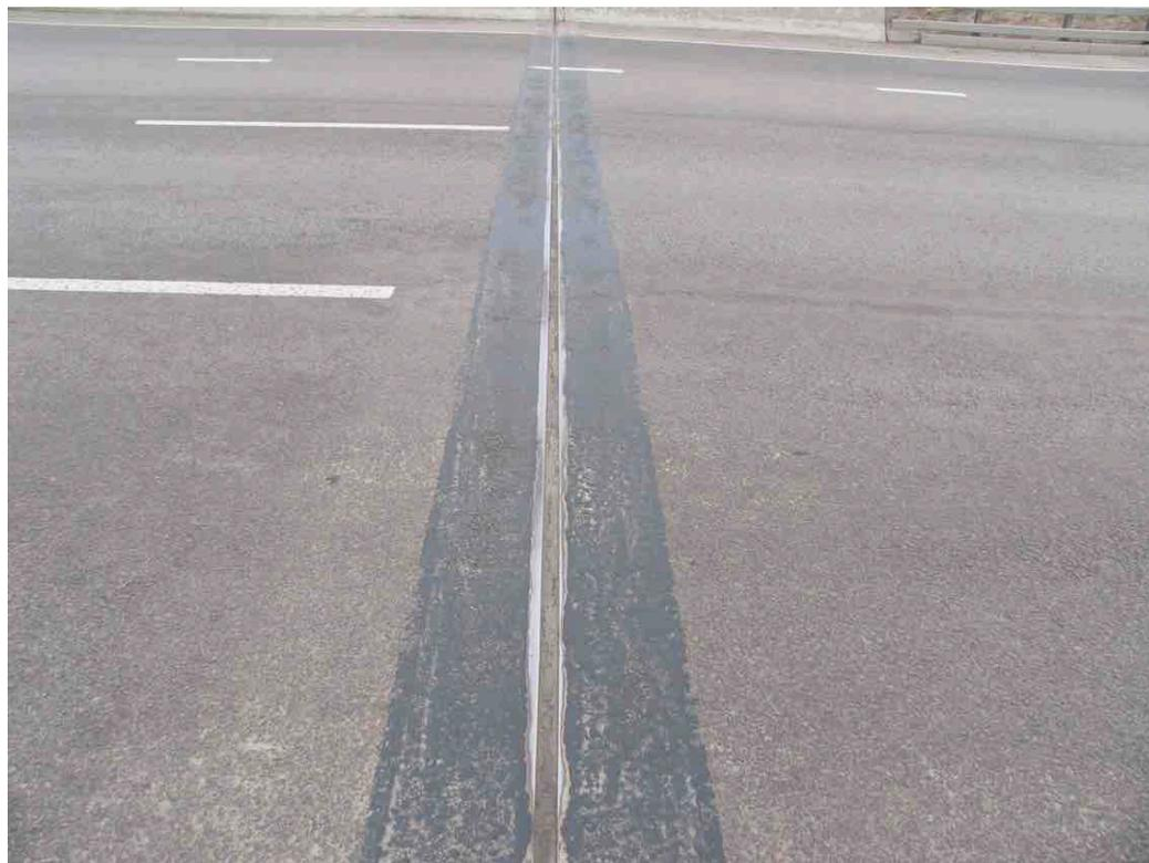
**Переходная зона сопряжения асфальтобетонного покрытия с деформационным швом - ПУГМК (VJ VAUM) на путепроводе на пересечении «Малого московского кольца» - км51 М-3 «Украина»**
