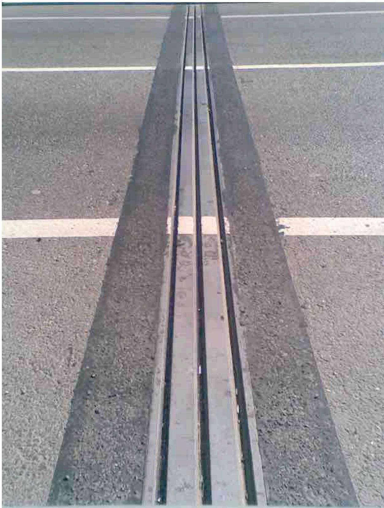
**Переходная зона сопряжения асфальтобетонного покрытия с деформационным швом - ПУГМК (VJ BAUM) на Эстакаде на ПК-54 автомобильной дороги Джубга-Сочи (Новороссийск-Тбилиси-Баку) на участке обхода г.Сочи.**
